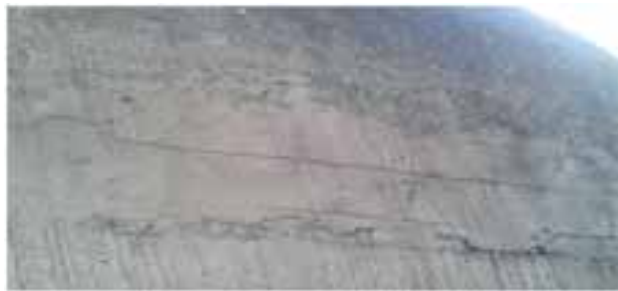
شکل ۶- آثار شن زدگی سطحی بتن
