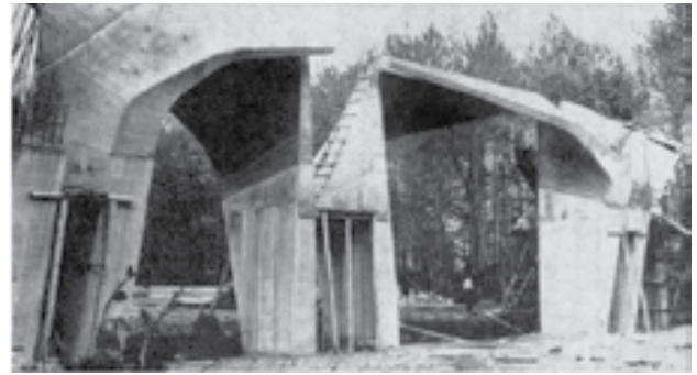
شکل ۲ - اجرای سردر دانشگاه تهران در زمان ساخت
