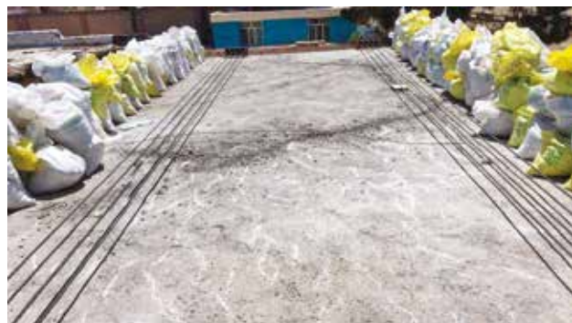
نمای به سمت پشت‌بام جهت بارگذاری از پشت‌بام ساختمان
