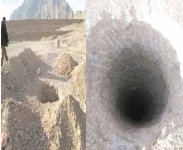
شکل ۱ - نمونه‌ای از چاهک‌های اکتشافی در آلوویوم (این چاهک‌ها می‌تواند تا عمق ۳۰ متر حفر شود)
