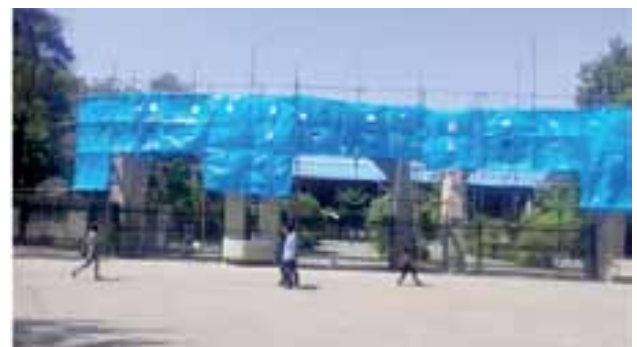
شکل ۷- شروع عملیات اجرایی ترمیم سازه سردر دانشگاه تهران
