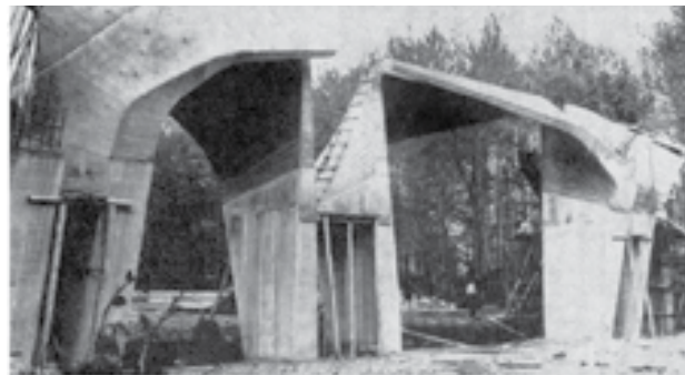
شکل ۲ - اجرای سردر دانشگاه تهران در زمان ساخت
