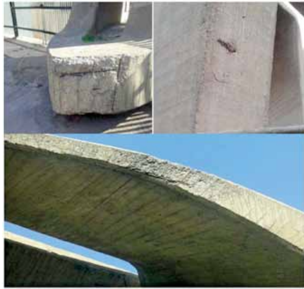
شکل ۵- آثار قلوه کن شدن بتن در محل آرماتور
