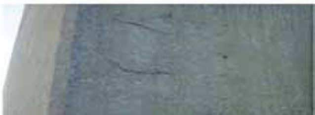
شکل ۴ - وضعیت ظاهری نامناسب سطح بتن
